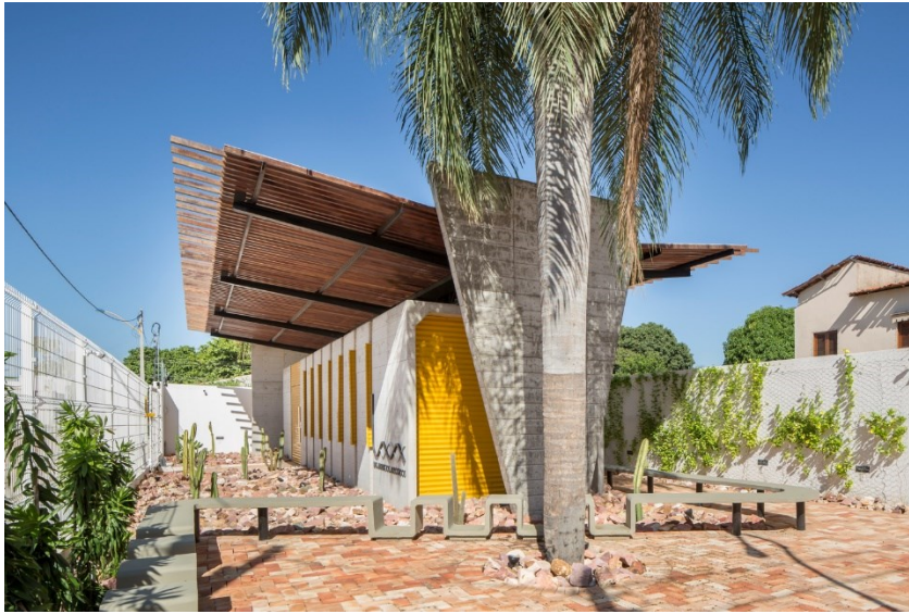
Figura 07: Imagem externa com destaque à sombra gerada pela coberta. Fonte: Fotografia de Joana França (LINS ARQUITETOS, 2019)
